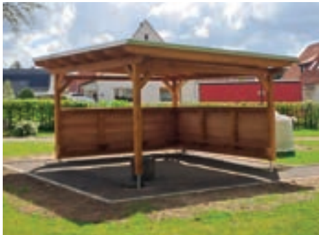
Nach dem Sturmschaden einer neuer Pavillon auf dem Friedhof.
